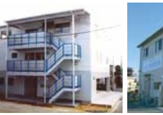
H12 コミュニケーションホール完成
