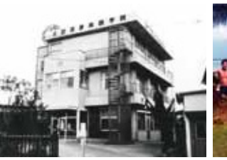
S51 本館完成
